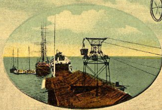
BRIGHTON PIER, LA BREA, TRINIDAD.
