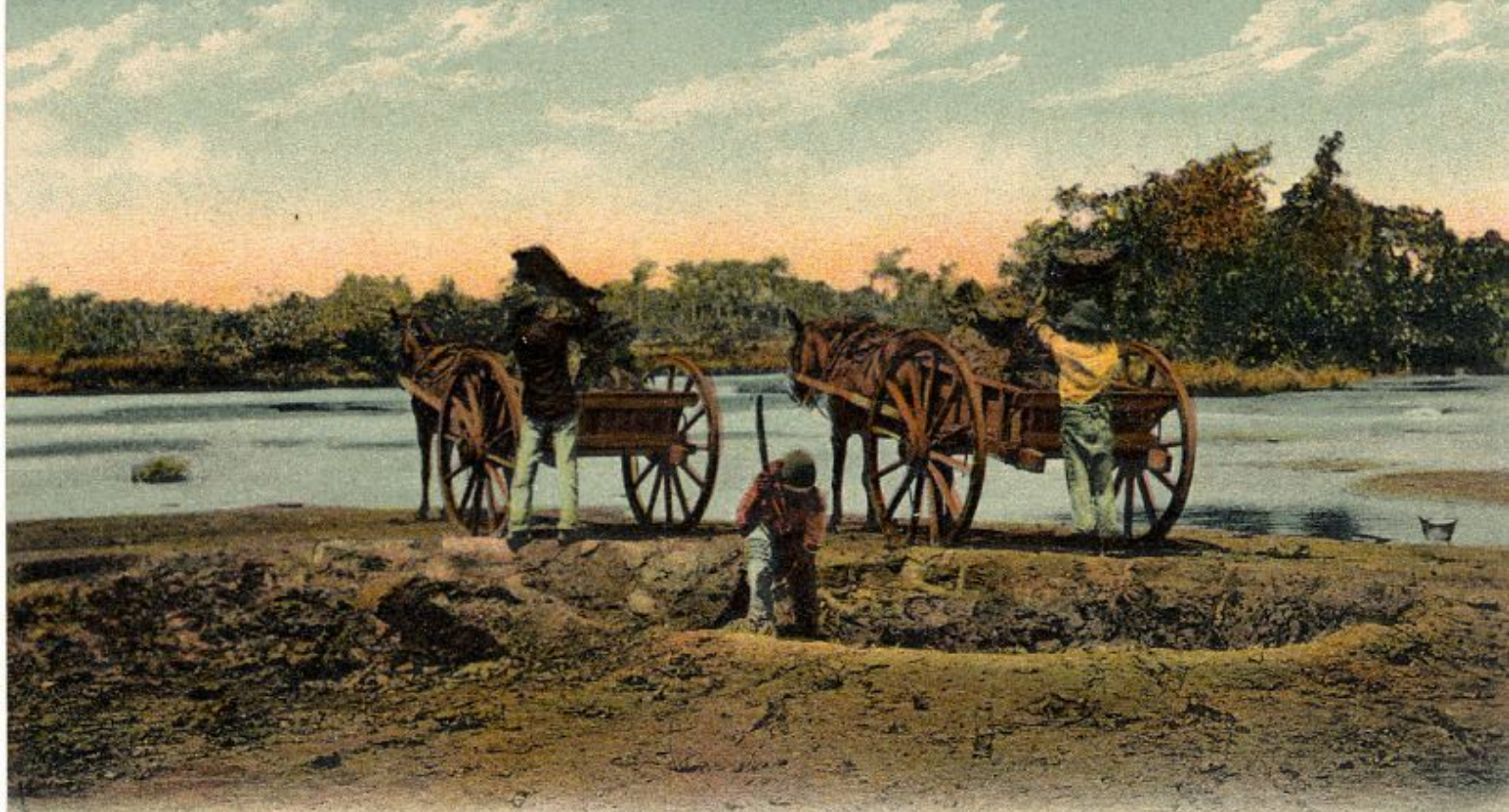
Digging Pitch, La Brea, Trinidad.
