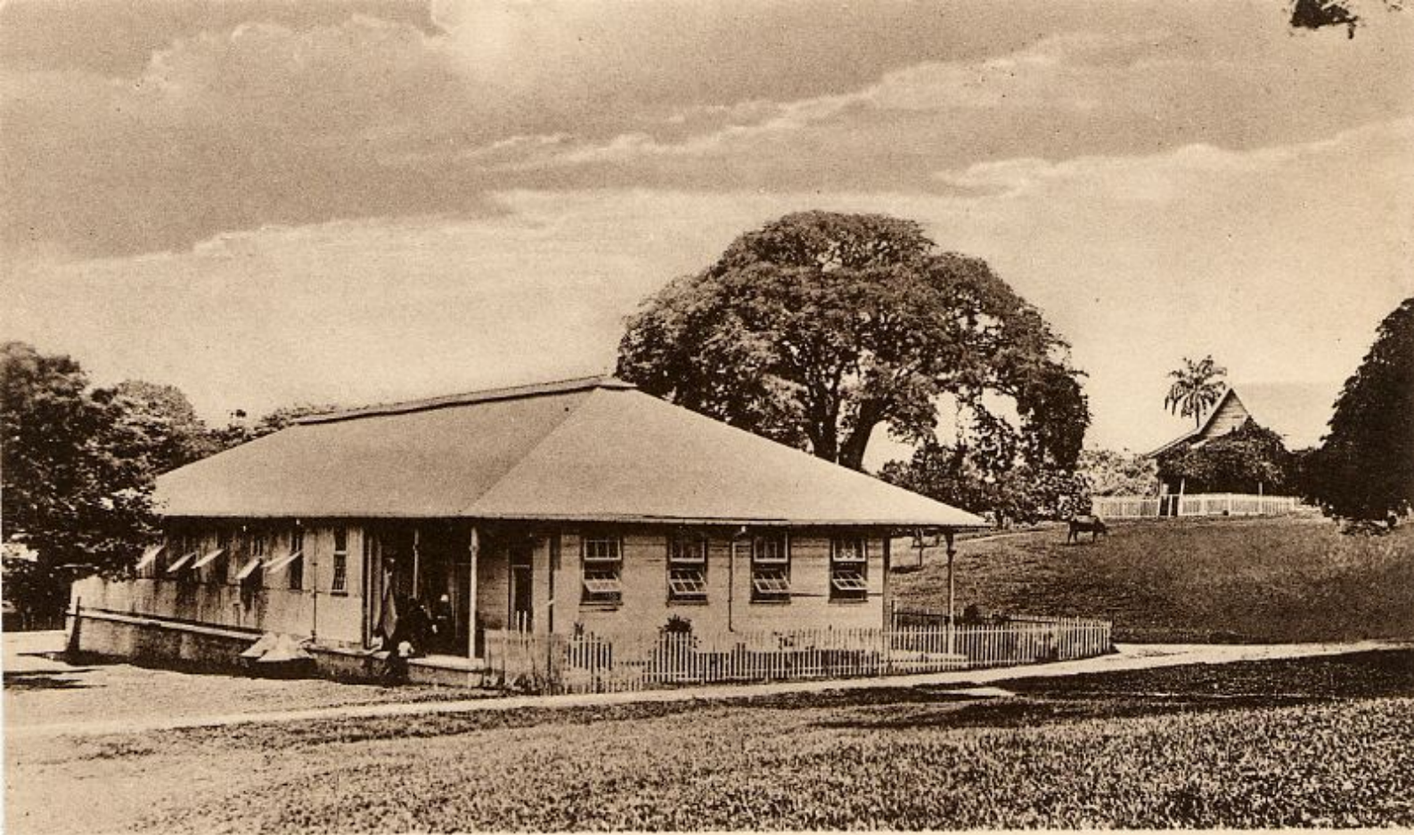
DRILL HALL, SAN FERNANDO, TRINIDAD, B. W. I.
