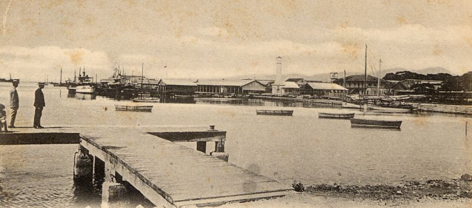
Trinidad. Port of Spain, Light House Jetty.
