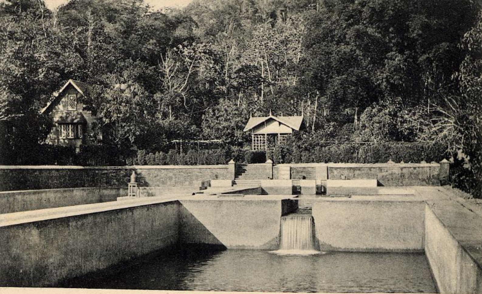
MARAVAL RESERVOIR, TRINIDAD. Wilsons Limited.
