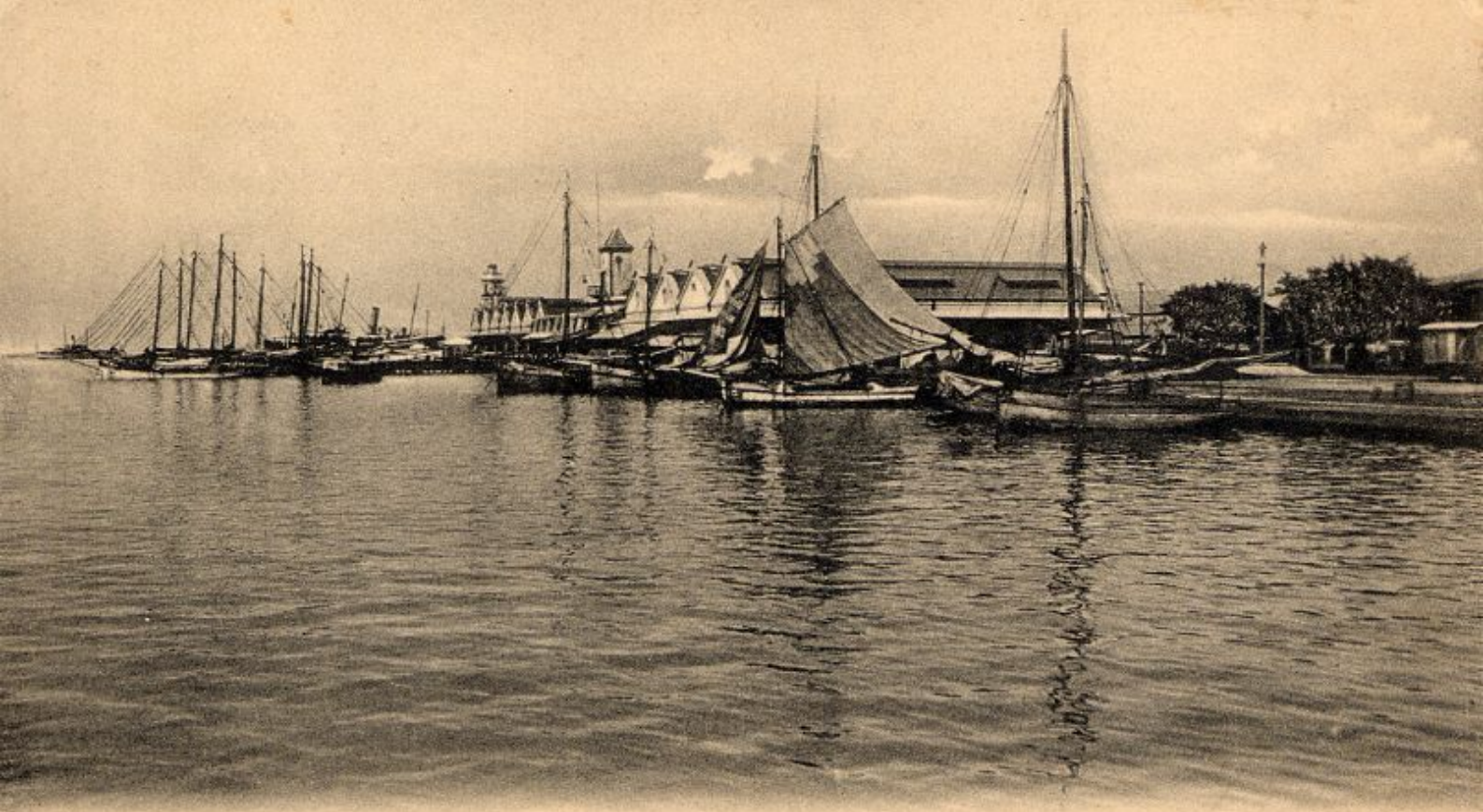
Custom House, Trinidad. B. W. I.
